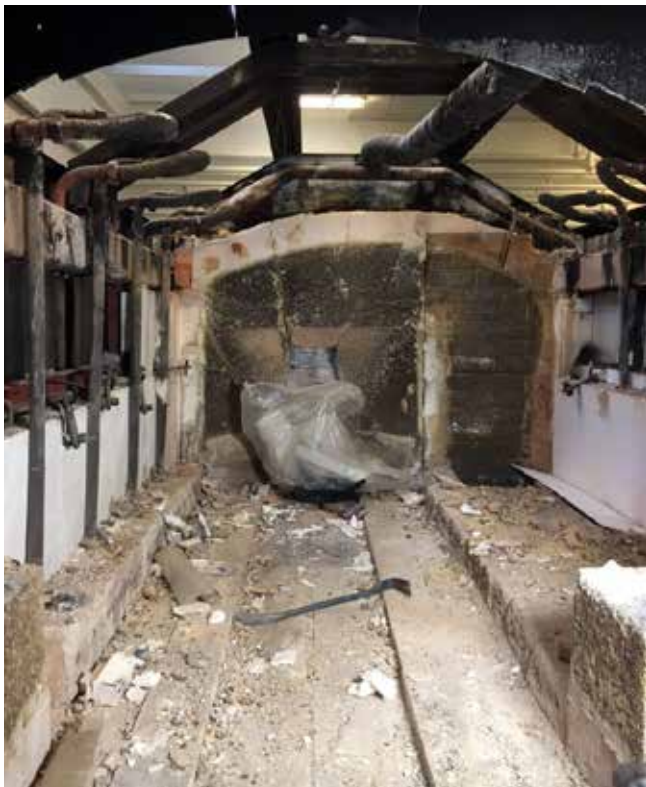
Den udtjente foring er fjernet.
